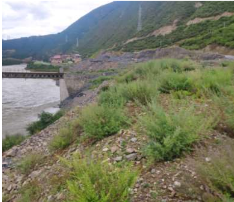
图 7-1 施工场地植被恢复
