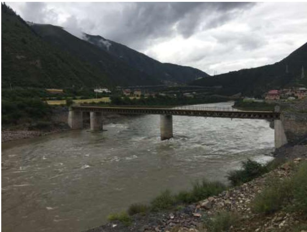
图4-2 相堆村交通桥全貌
