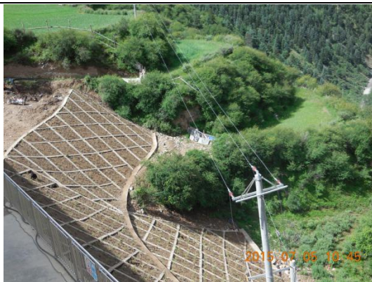
吉龙变电站边坡防护和绿化
