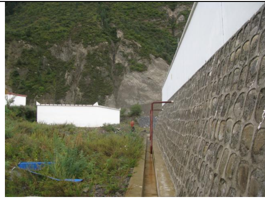
共科变电站排水及拦挡
