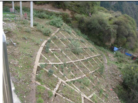
共科变电站边坡防护和绿化
