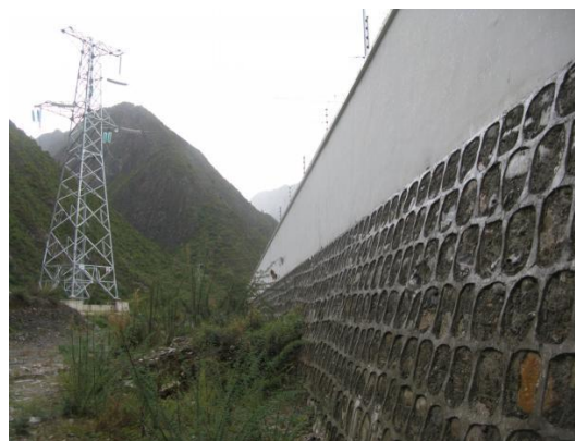
共科变电站外排边坡挡护
