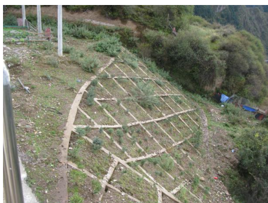
吉龙变电站站外边坡防护及绿化
