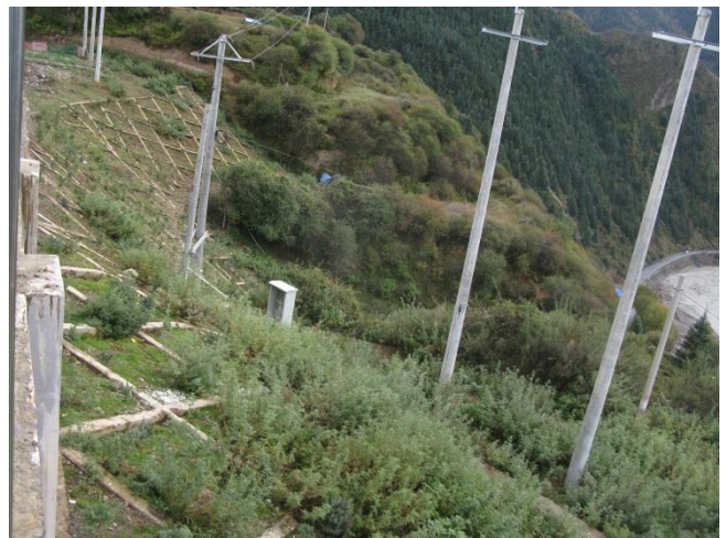
吉龙变电站站外边坡防护及绿化
