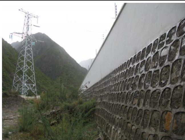
共科变电站外排边坡挡护
