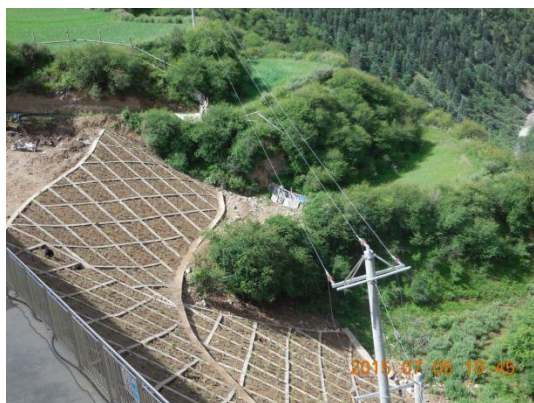
吉龙变电站站外边坡防护及绿化
