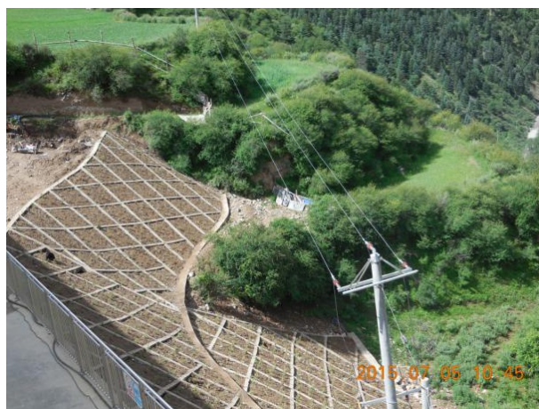
吉龙变电站站外边坡防护及绿化（2015.7）
