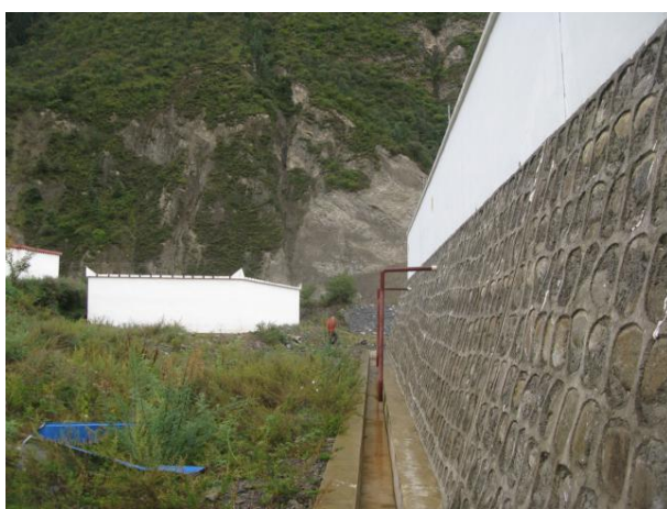
共科变电站外排水（2018.10）
