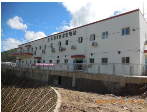
吉龙变电站面貌（2015.7）
