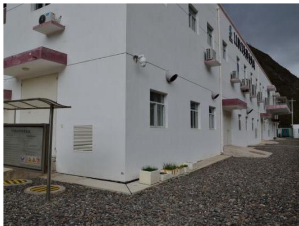
共科变电站围墙内场地铺碎石（2018.10）
