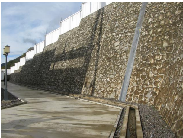
吉龙变电站内排水沟及拦挡（2018.10）
