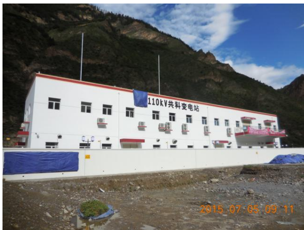
共科变电站面貌（2015.7）
