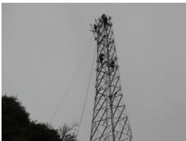
吉共线路组塔（2014.7）
