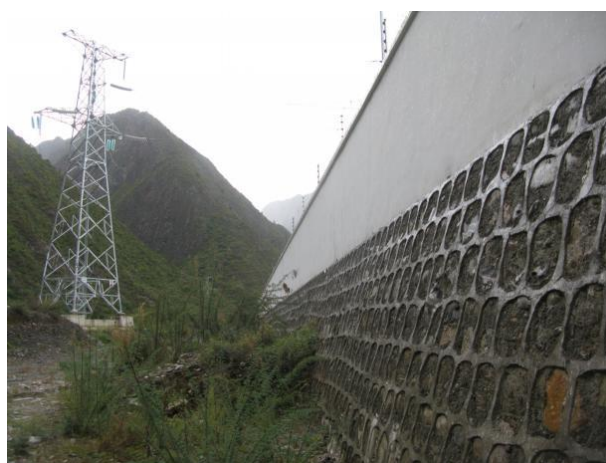
共科变电站外排边坡挡护（2018.10）
