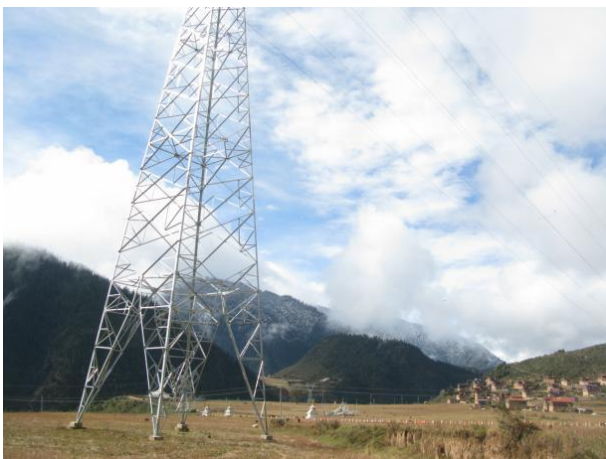
仁吉线路塔基面貌（2018.10）
