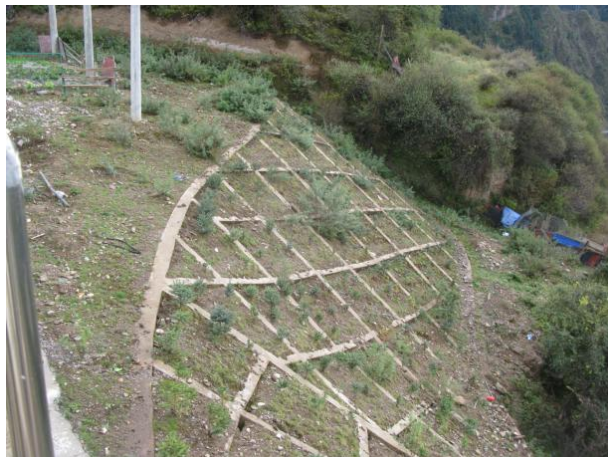
吉龙变电站站外边坡防护及绿化（2018.10）
