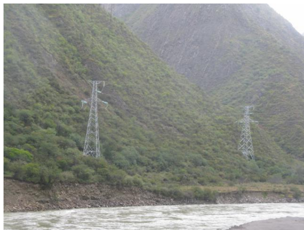
吉共线路面貌（2018.10）
