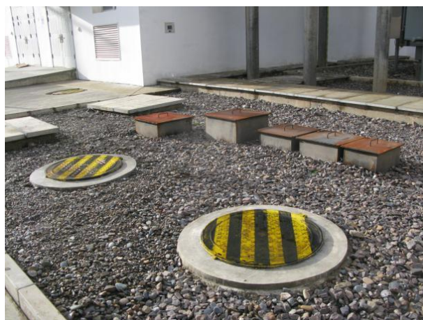
吉龙变电站围墙内场地铺碎石（2018.10）
