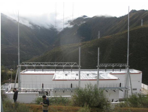
吉龙变电站面貌（2018.10）
