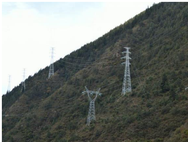
仁吉线路面貌（2018.10）
