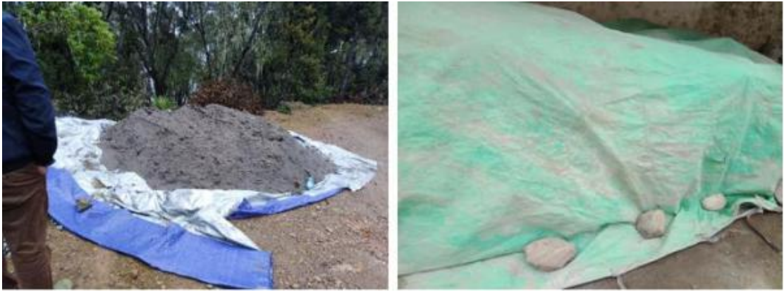
图 8-7 水泥进行防扬尘处理
