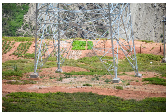
图 8-4 N10 塔植被恢复情况
