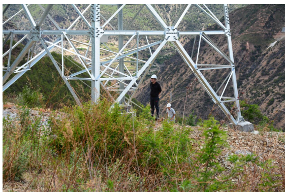
图 8-3 N7 塔植被恢复情况
