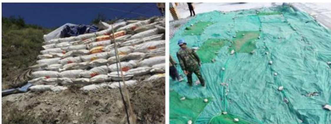
图 8-6 落实临时挡土措施，减少水土流失（N122 挡墙外）
