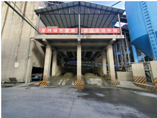
高线混凝土系统压滤后的泥渣
