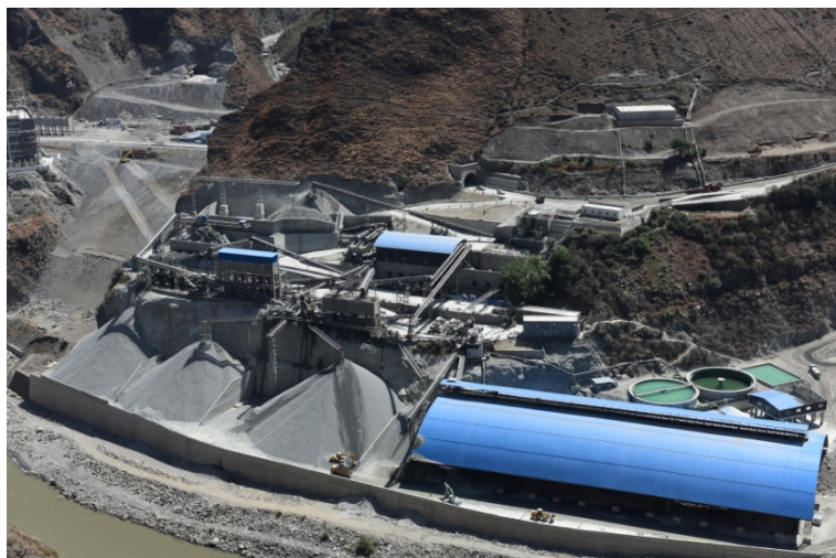
图 2.3-12 上铺子沟砂石加工系统
