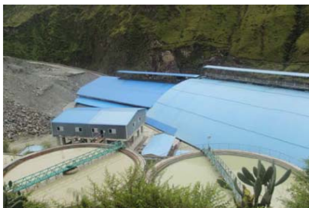
图 4.1-2 砂石加工生产系统生产废水处理设施（辐流沉淀池）
