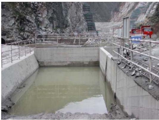
低线混凝土系统废水沉淀池
