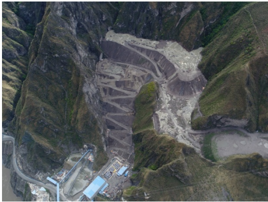
上铺子沟渣场底部设置挡墙护坡
