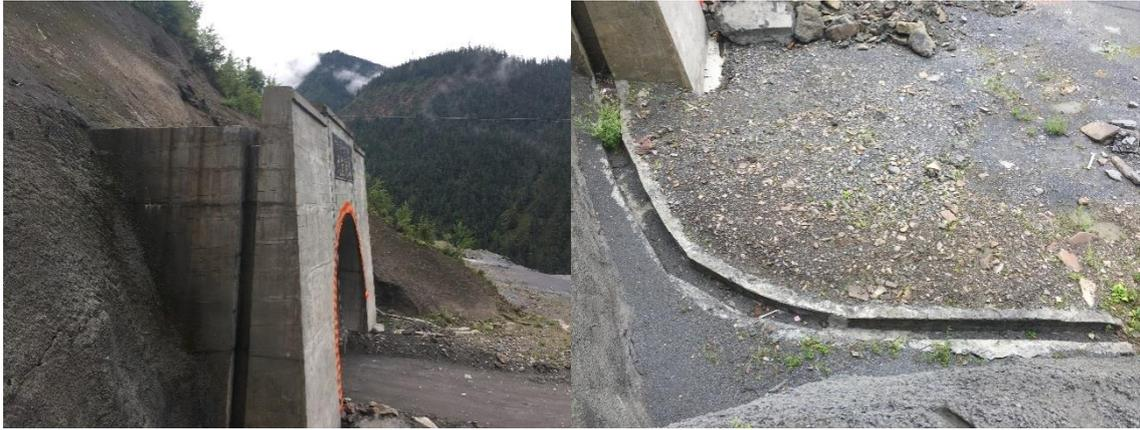
图 4.1-1 尺措隧道洞脸截排水沟
