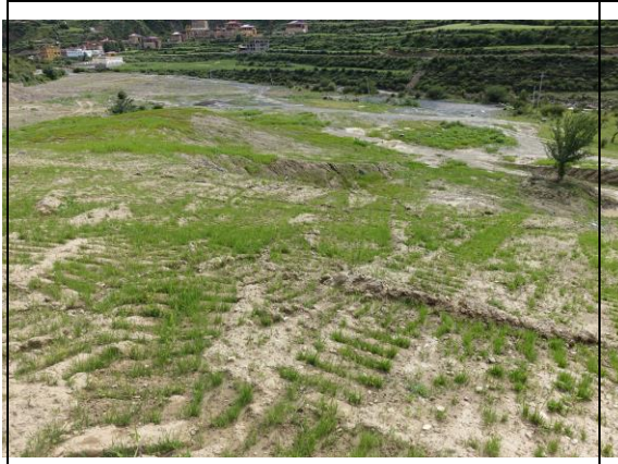
弃渣场区土地整治及植草
