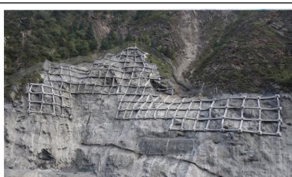
插图 3-2 边坡治理区现场照片 2
