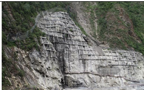
插图 3-1 边坡治理区现场照片 1
