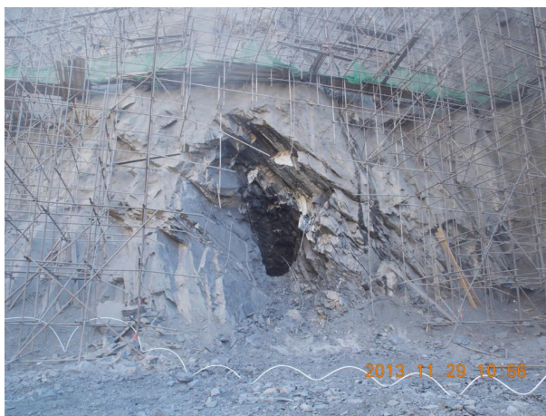
导流洞进口边坡支护（2013.11）
