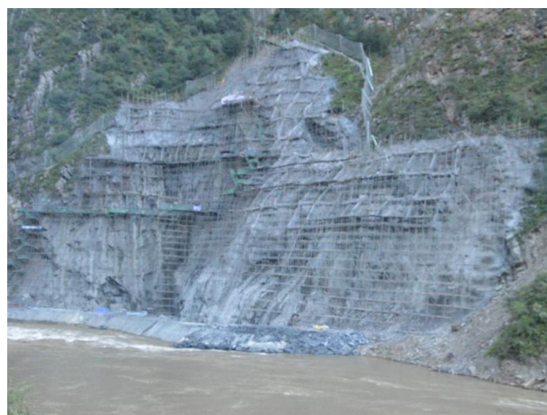
导流洞进口边坡支护（2014.9）
