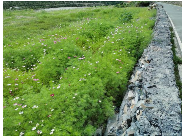
渣场挡墙及绿化 (2020.8)
