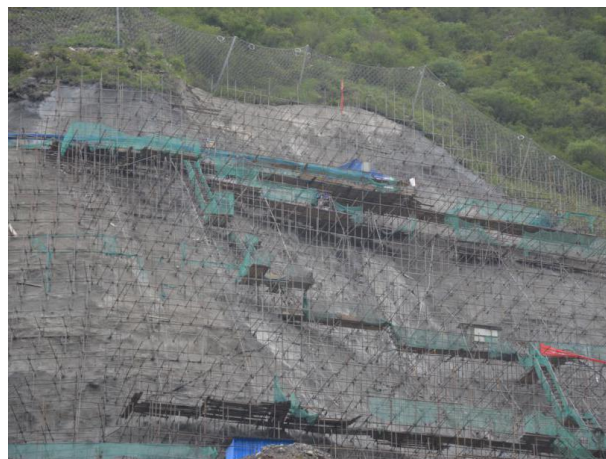
导流洞出口边坡支护（2014.7）
