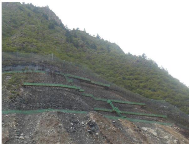
导流洞出口边坡支护（2013.9）
