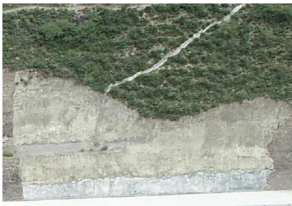
路基工程区现场（排水沟）
