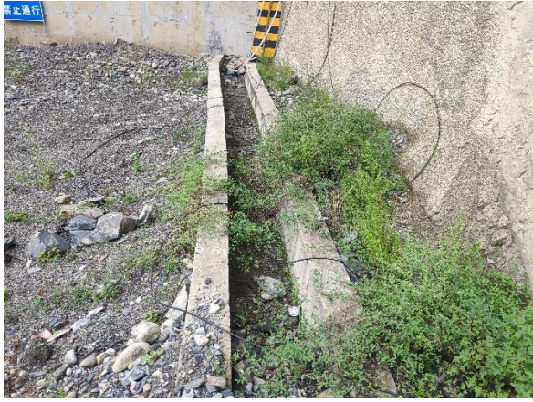
隧洞入口现场（排水沟）
