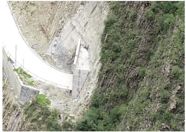
隧洞出口现场
