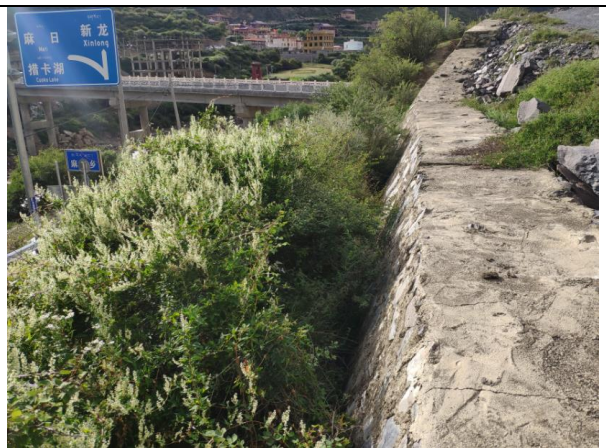
插图 3-7 弃渣场区防护工程
