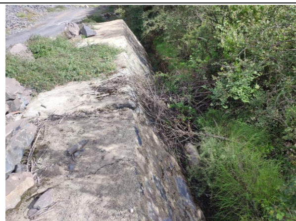
插图 3-7 弃渣场区防护工程
