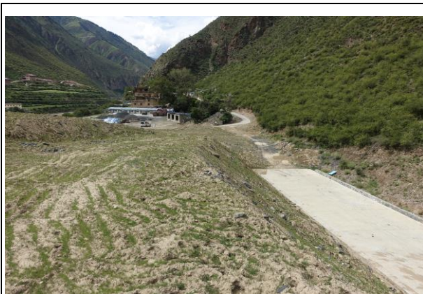
弃渣场区覆土植草
