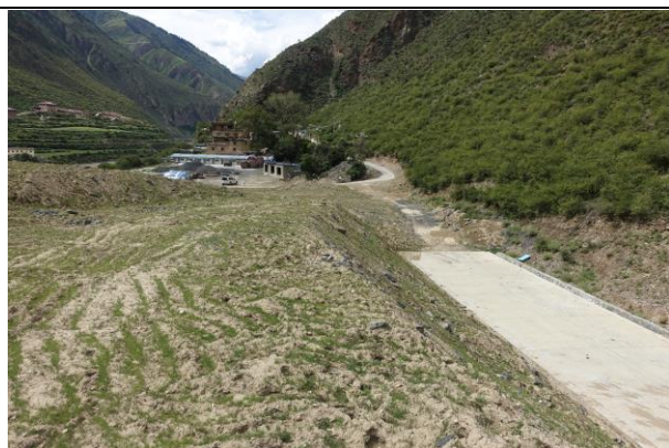
插图 3-5 渣场区现场查勘
