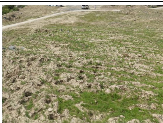
弃渣场区覆土植草
