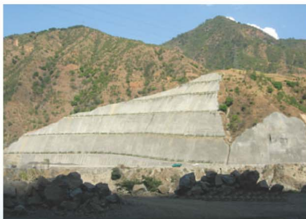
左岸上坝改线公路工程
