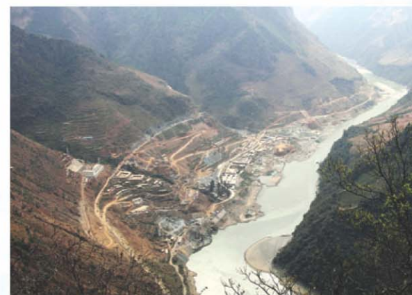
打保施工区全景（业主临时营地）
