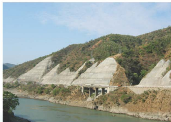
右岸改线公路工程
