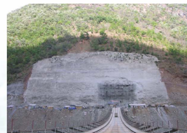
上游索桥左桥台滑坡体处理工程
