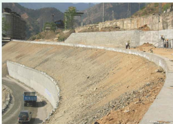
S214改线公路
