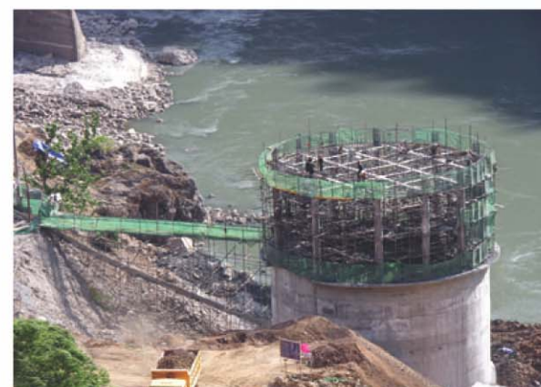
施工中的打保供水系统取水泵站
