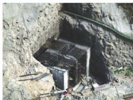
右岸导流洞工程进口
