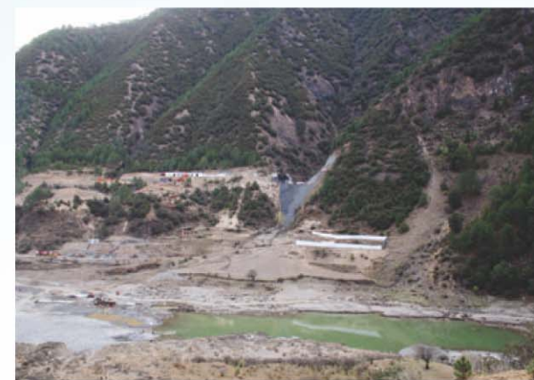
大梁子隧道出口工程
