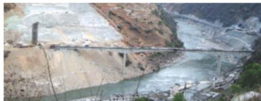
已建成的锦屏东桥
