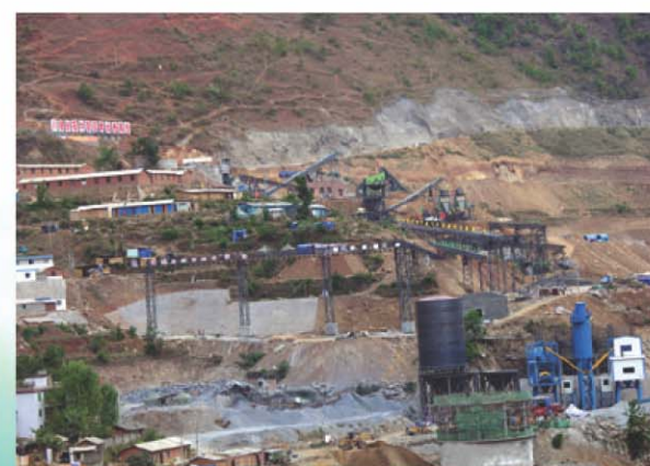
施工中的打保砂石料加工系统
