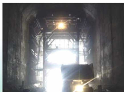
已衬砌的右岸导流洞出口段
