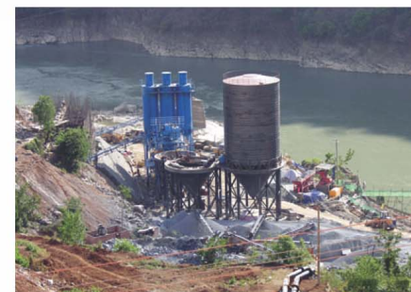
施工中的打保混凝土拌合系统
