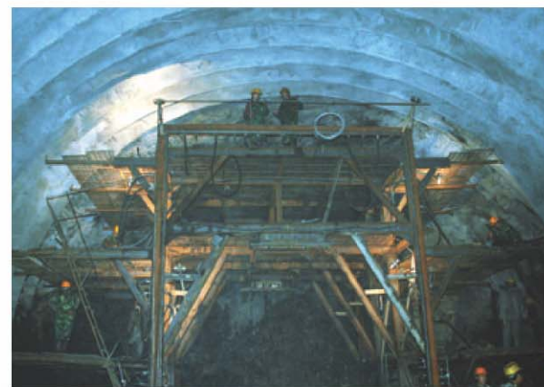
大梁子隧道施工现场
