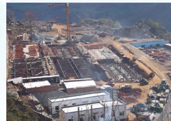
建设中的大盐池承包商营地
