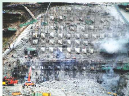
左坝肩缆机平台边坡锚索施工
