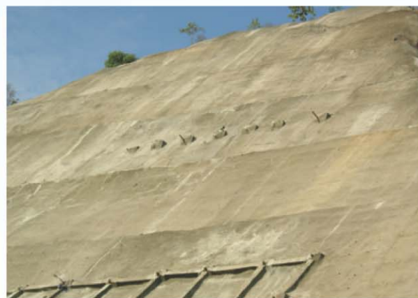
右岸改线公路高边坡工程
