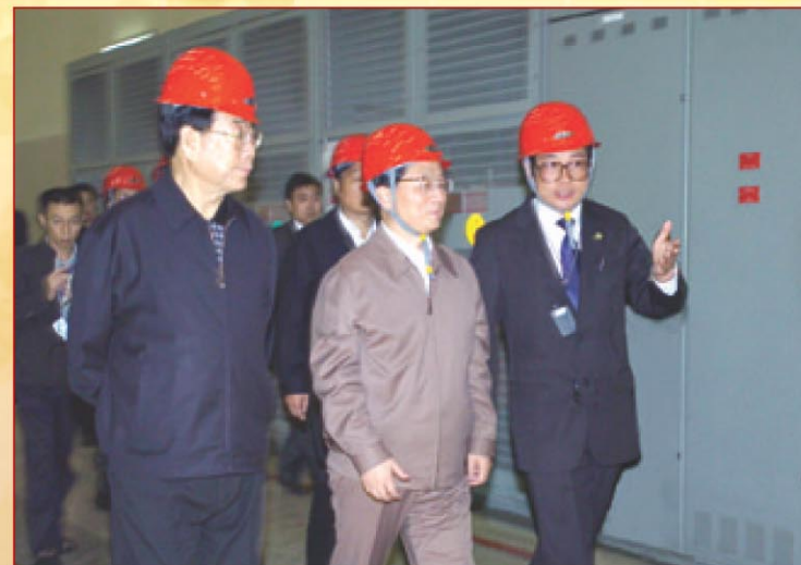
黄菊同志在陈云华总经理的陪同下视察二滩水电站地下厂房
