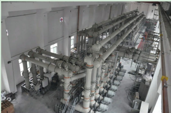
GIS设备安装完成
