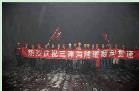
三滩沟隧道顺利贯通
