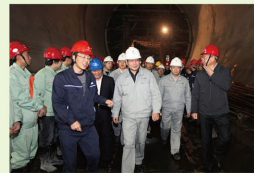
检查锦屏水电站施工现场
