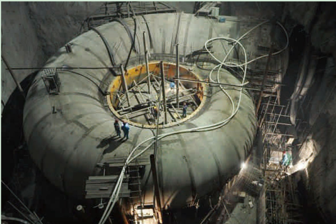
2011年12月30日4#机组蜗壳水压试验完成
