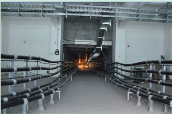
500kV 电缆安装完成
