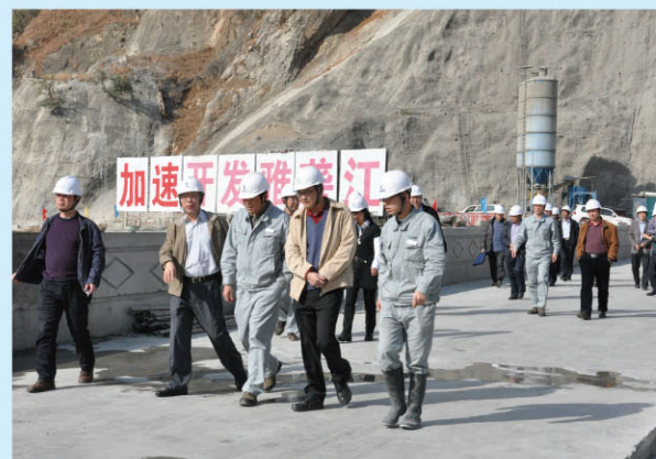
检查组查看工程现场
