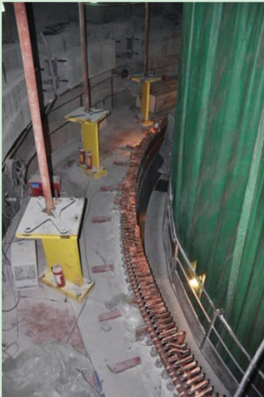
3#机组定子组装完成，即将开始叠片
