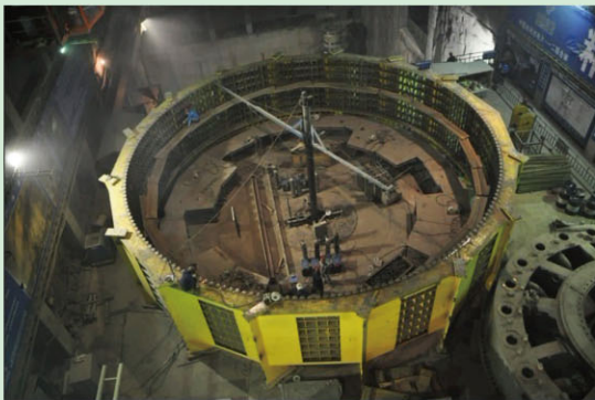
2#机组定子上、下层线棒安装完成
