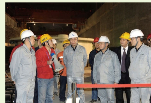
检查官地水电站施工现场
