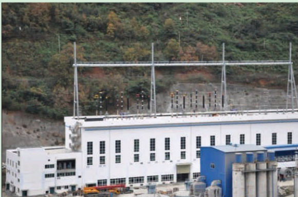
500kV 出线构架安装完成
