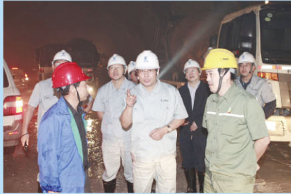
公司总经理陈云华在1#引水隧洞施工现场检查工作
