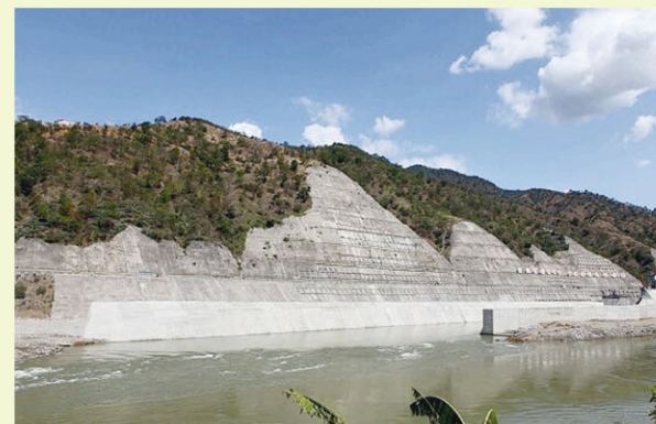
导流明渠下游围堰拆除后过流全貌
