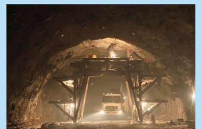
施工中的锦屏二级水电站1#引水隧洞
