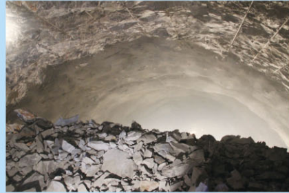
1#引水隧洞全线贯通
