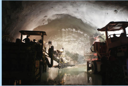
1#引水隧洞施工
