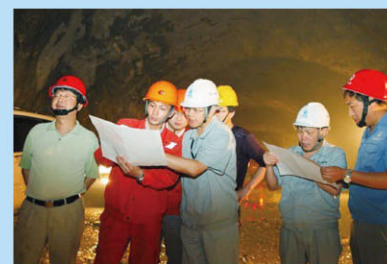
锦屏建设管理局领导在掌子面检查施工进度情况
