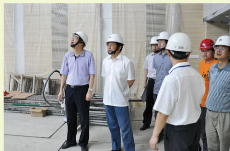
检查正进行设备安装施工的集控值班大厅
