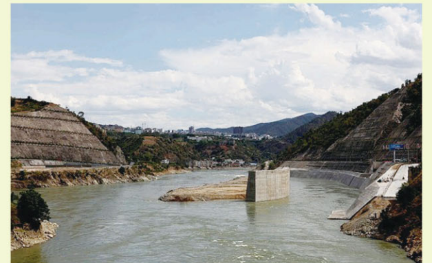
导流明渠上游围堰拆除后过流全貌
