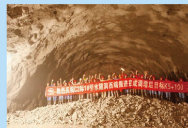
锦屏二级水电站1#引水隧洞西端掘进至K5+100m桩号
