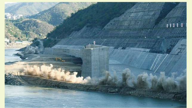
导流明渠上下游围堰同时起爆
