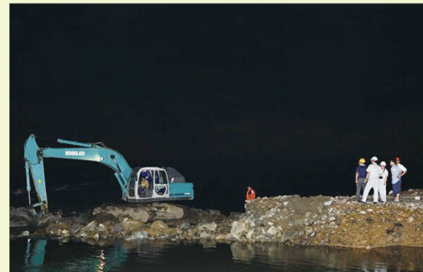
利用夜间来水较少的时机实施围堰拆除
