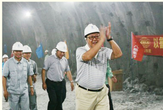
王会生董事长在2号引水隧洞贯通点慰问建设者
