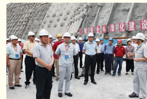
冯士栋总裁等检查锦屏一级大坝施工进度情况
