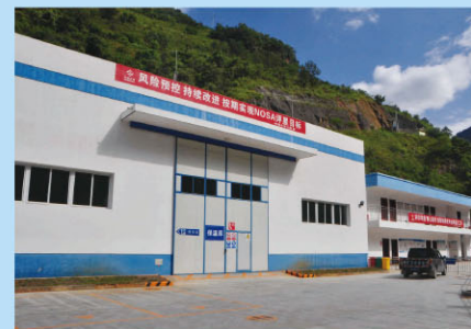
官地水电站机电仓库近景
