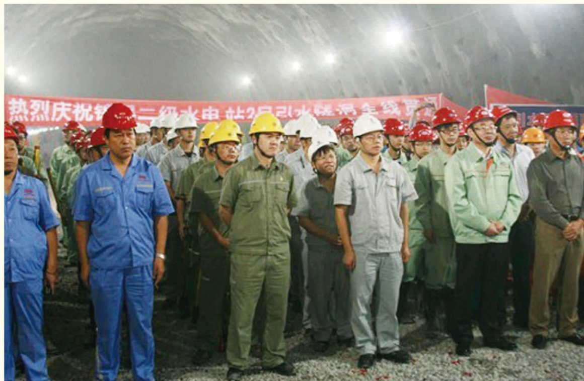
锦屏水电站建设者代表在2号引水隧洞贯通点聆听董事长讲话
