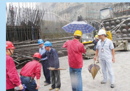
检查大坝仓面施工质量
