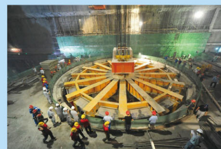
2号机定子顺利吊入机坑
