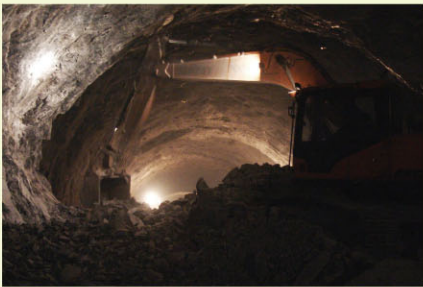
贯通点形象面貌
