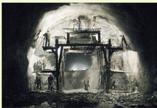
导洞贯通后扩挖
