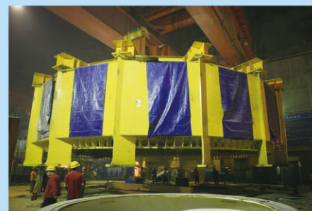
2号机定子在安装间作起吊检查
