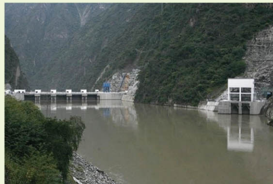
拦河闸坝蓄水后上游形象
