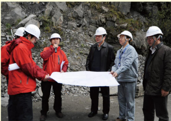
陈云华总经理在雅砻江上游新龙段的电站项目点工地进行现场办公
