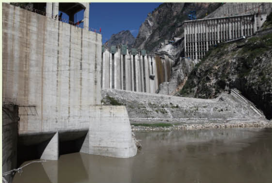
左岸导流洞两扇闸门成功下闸
