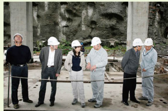
检查导流洞下闸准备情况
