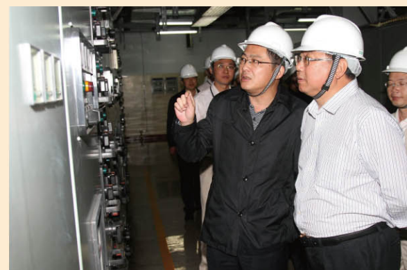
监管检查组在二滩电厂生产现场检查
