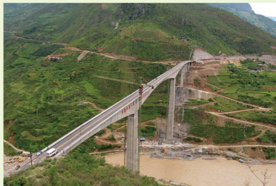
小金河大桥全貌
