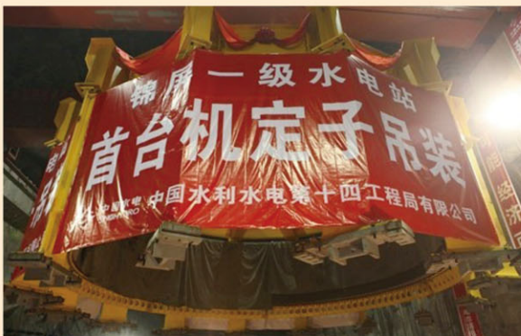
首台机组发电机定子吊装
