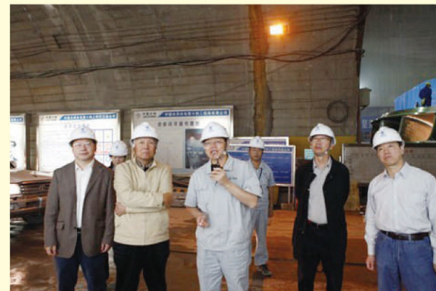
在锦屏级水电站建设工地调研
