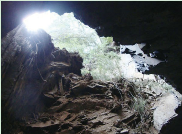
麻地湾隧道出口贯通
