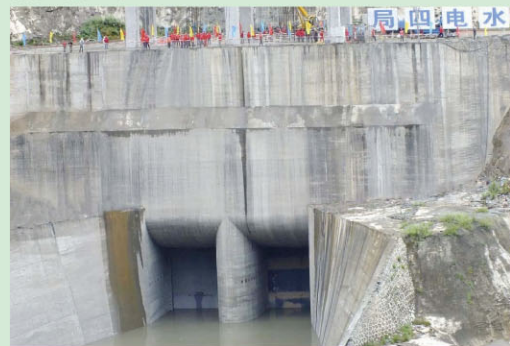
左岸导流洞两扇闸门成功下闸
