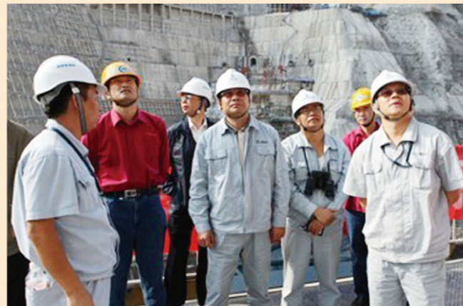
检查工程建设情况
