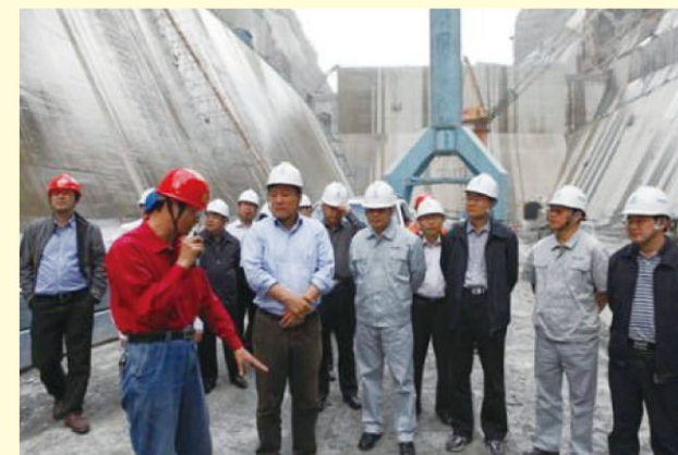
矫勇副部长一行在锦屏水电站工地考察
