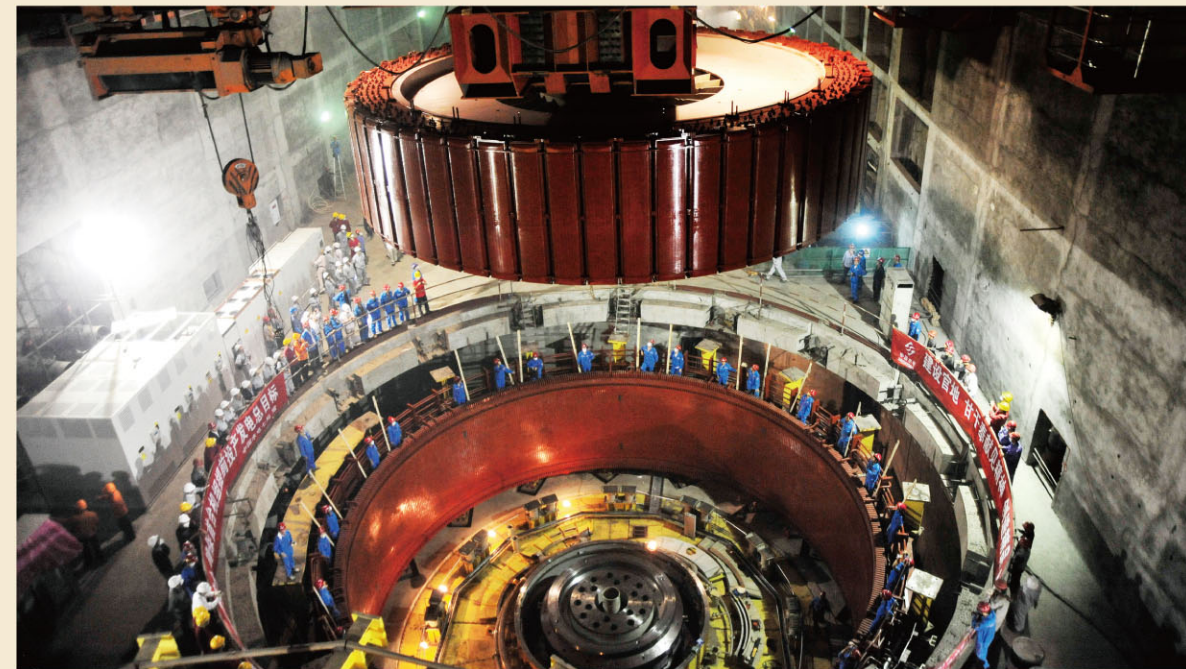
官地水电站1#机组转子吊装 张超锋
