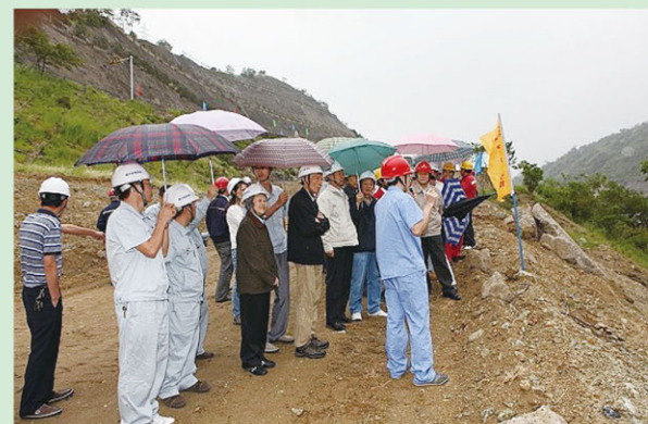
查勘工地现场
