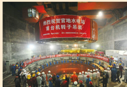
首台机转子平稳吊装
