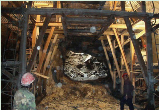
麻地湾隧道导洞贯通
